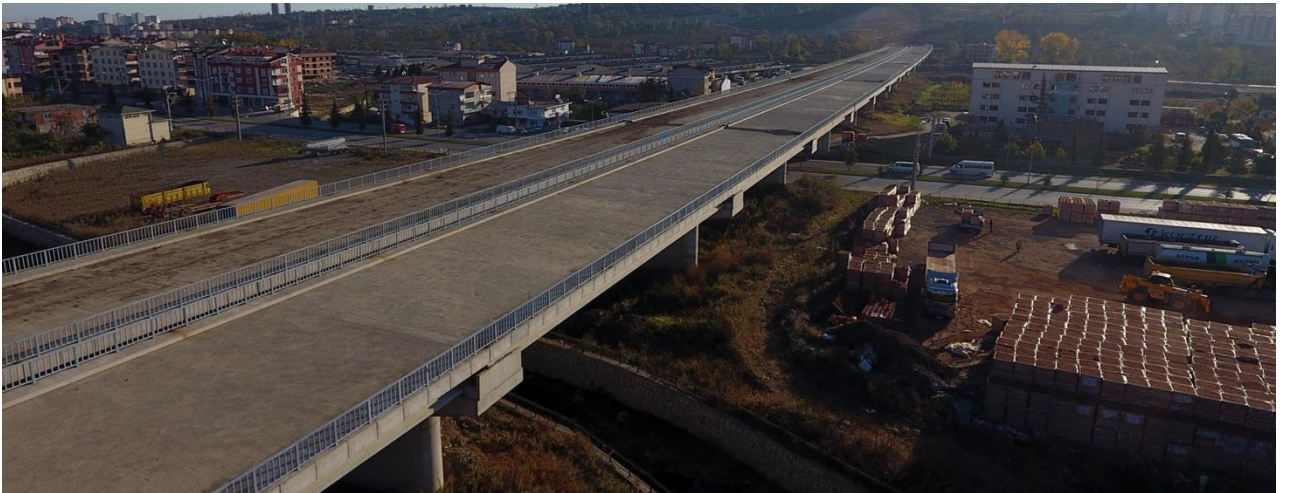
Viyadük İnşaatı Genel Görünüm General View of Viaduct Construction
