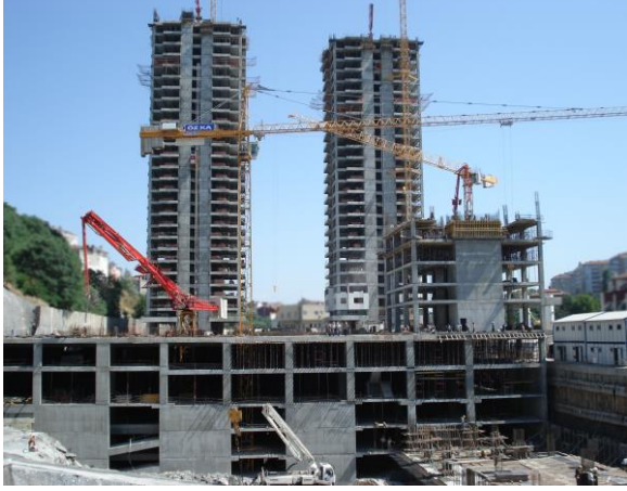
Kaba İnşaat İşleri Görünümü View of the Rough Construction Works
