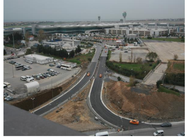
VIP Giriş İnşaatı Görünümü. View of the VIP Entrance Construction.
