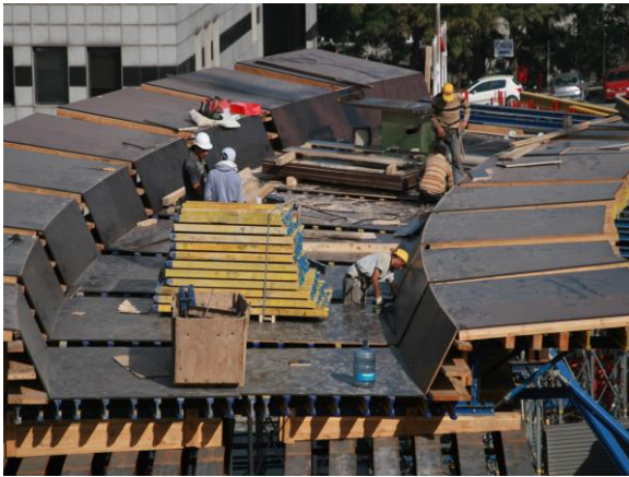
Yerinde Dökme Betonarme Köprü Kalıp İmalatları Görünümü. View of Formworks of the Cast in Place Reinforced Concrete Bridge.
