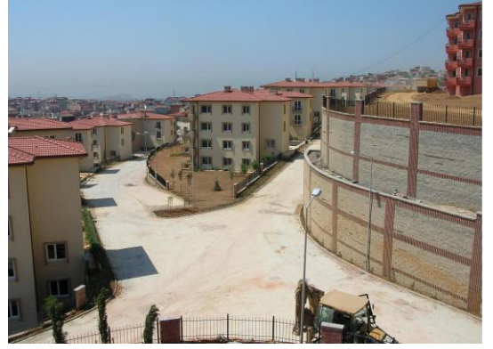
Site Yollarının Görünümü View of the Inner Roads
