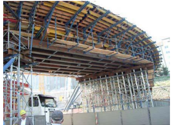
42 m Açıklıklı Art Germe Köprü İmalatı Görünümleri. Views of the Construction of the Post-tensioning Bridge with 42 m Span.
