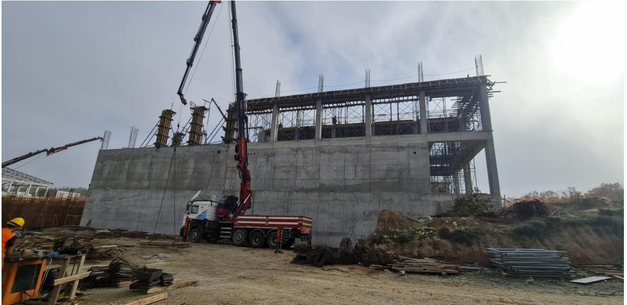
Projenin İnşaatından Genel Görünüm General View of the Project Construction.
