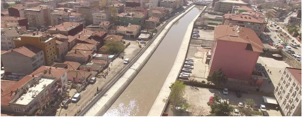
Hattın Genel Görünümü General View of the Project
