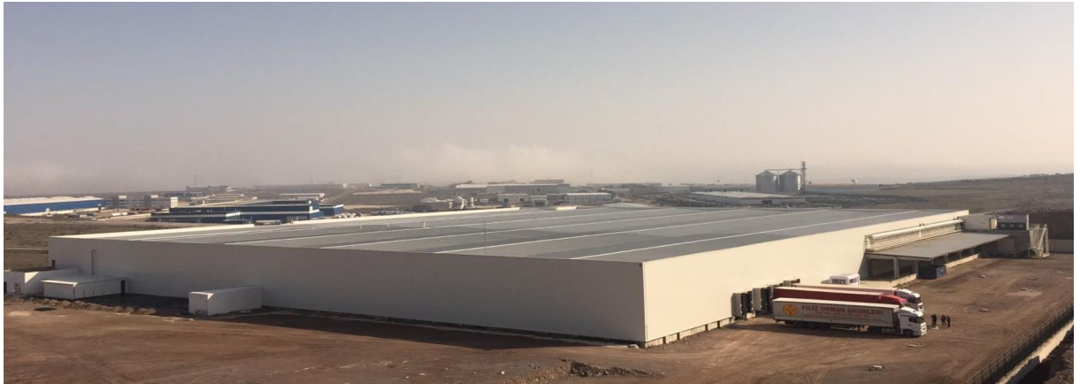
İnşaat Sahasından Genel Görünüm General View of Construction Site
