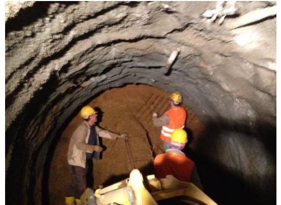
Tünel İnşaatı Görünümü. View of the Tunnel Construction.
