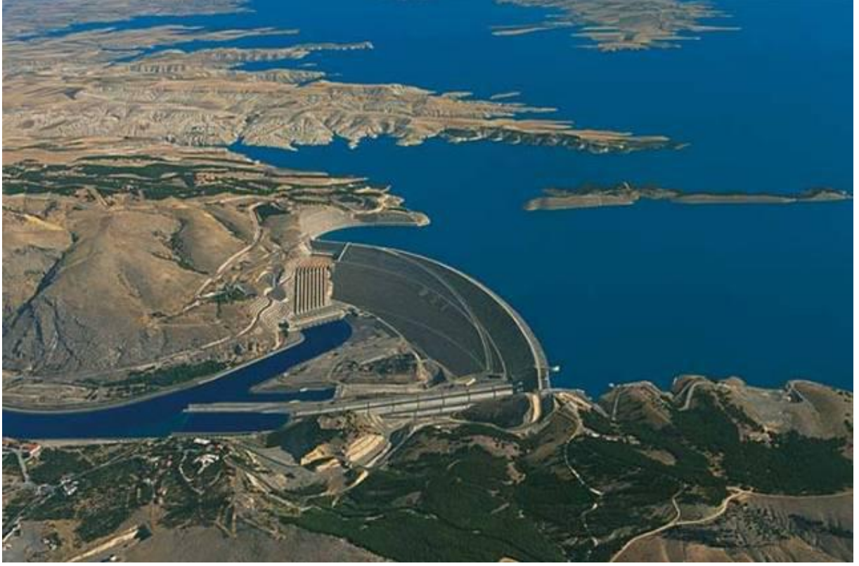
Atatürk Barajı'nın Genel Görünümü. General View of the Atatürk Dam.
