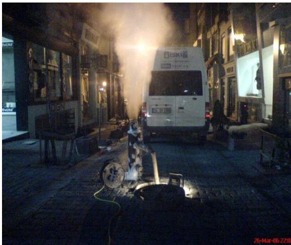
Hattın İçindeki Kaplamanın Basıncılı Sıcak Hava ile Kurutulmasının Görünümü
