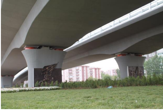
Viyadük Görünümü View of the Viaduct
