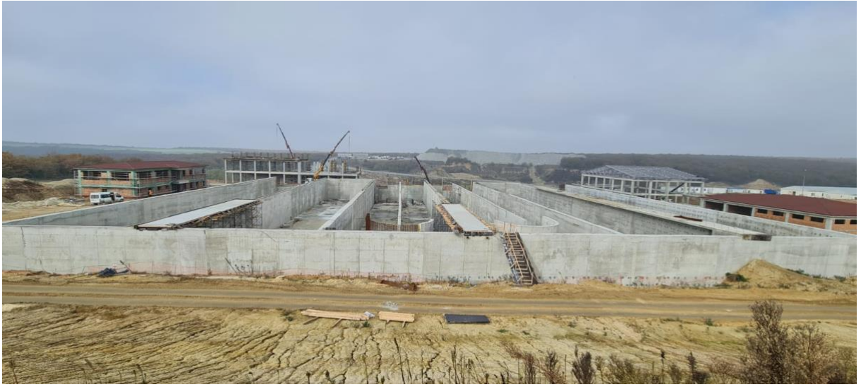
Projenin İnşaatından Genel Görünüm General View of the Project Construction.
