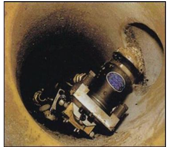
Ev Bağlantılarının Freze Makinesi ile Tekrar Açılmasının Görünümü
