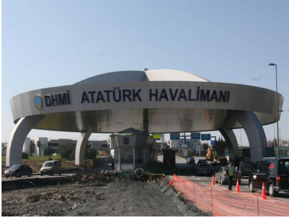
Kanopi İnşaatı Görünümü. View of the Canopy Construction.
