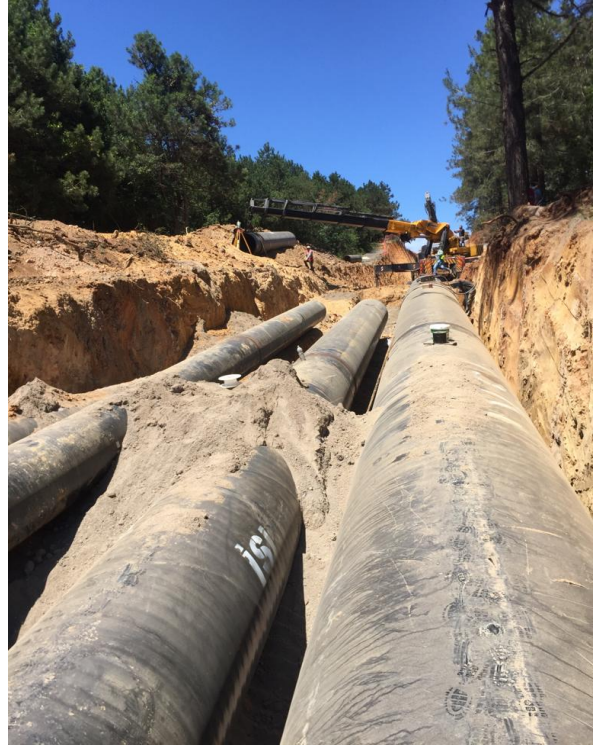
Hattın Genel Görünümü-2 General View of the Transmission Line-2
