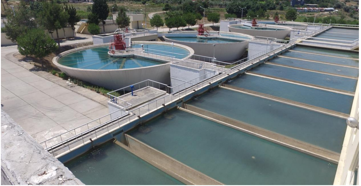
Tesisin Genel Görünümü.
