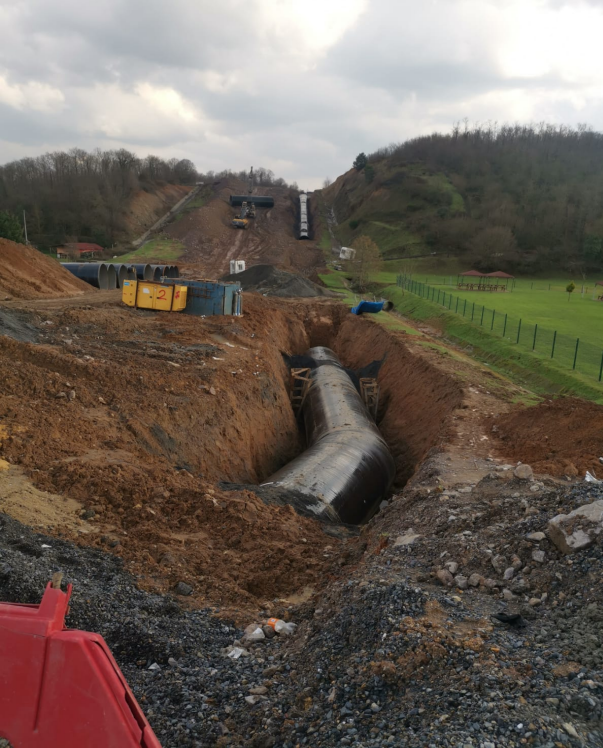
Hattın Genel Görünümü-1 General View of the Transmission Line-1
