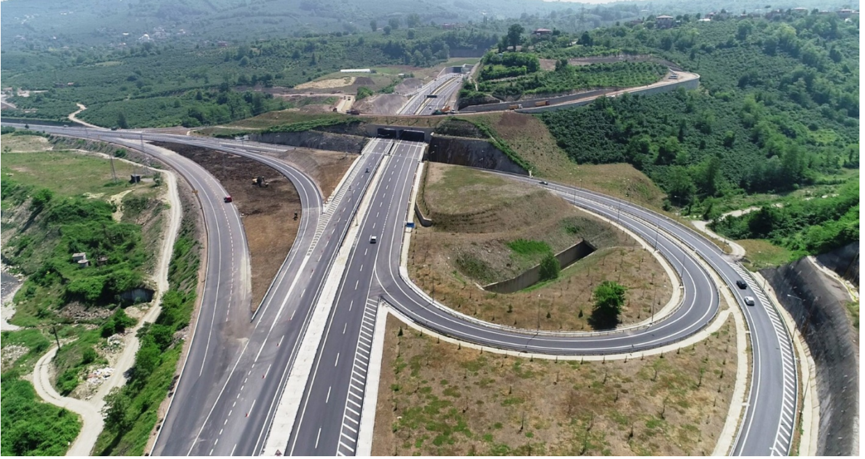
Yol İnşaat Alanından Genel Görünüm
