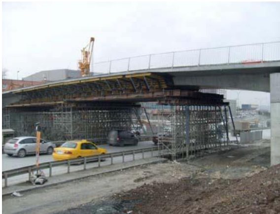
42 m Açıklıklı Art Germe Köprü İmalatı Görünümleri. Views of the Construction of the Post-tensioning Bridge with 42 m Span.
