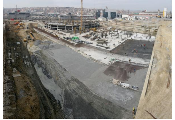
İnşaat Sahasının Genel Görünümü General View of the Construction Site
