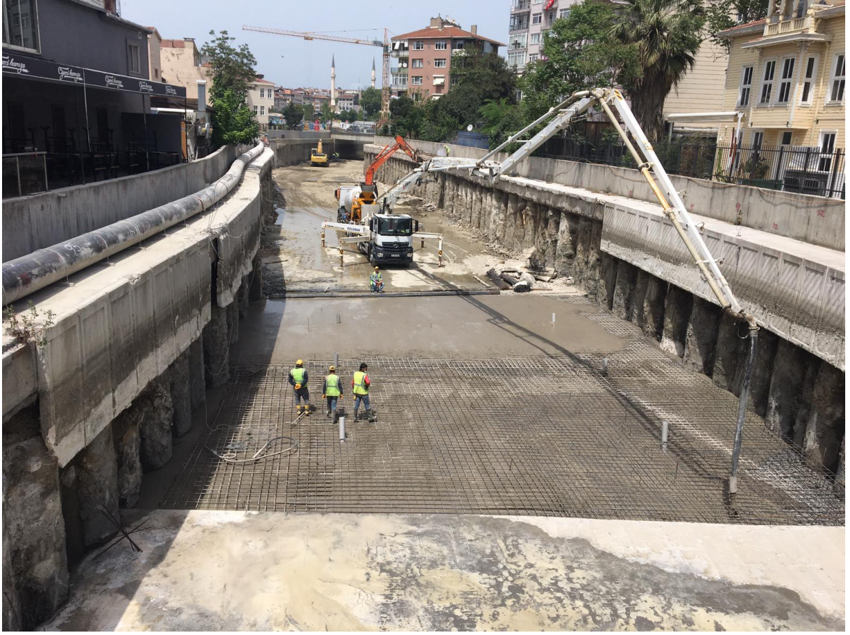
Kanal Hattı Beton İmalatları
