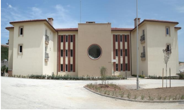
Bina Arka Görünümü Rear View of the Building
