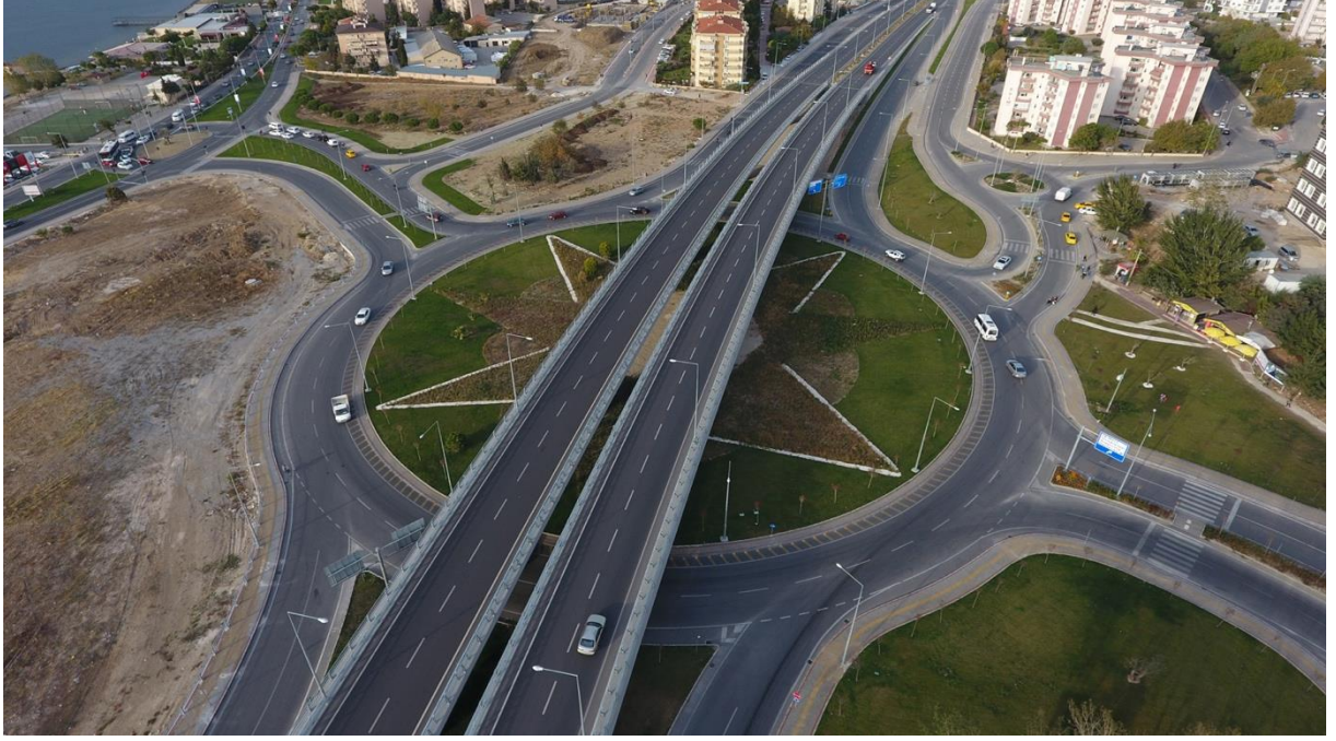
Kavşak Bağlantı Görünümü Intersection View
