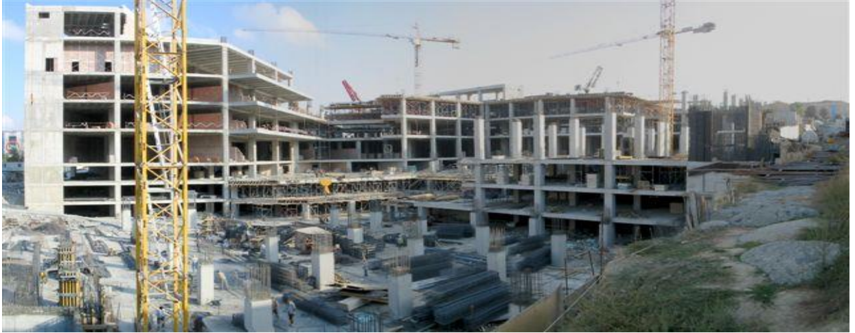
İnşaat Sahasının Genel Görünümü General View of the Construction Site
