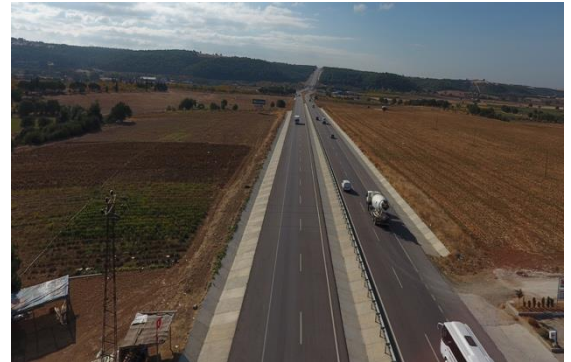
Yolun Genel Görünümü General View of the Road
