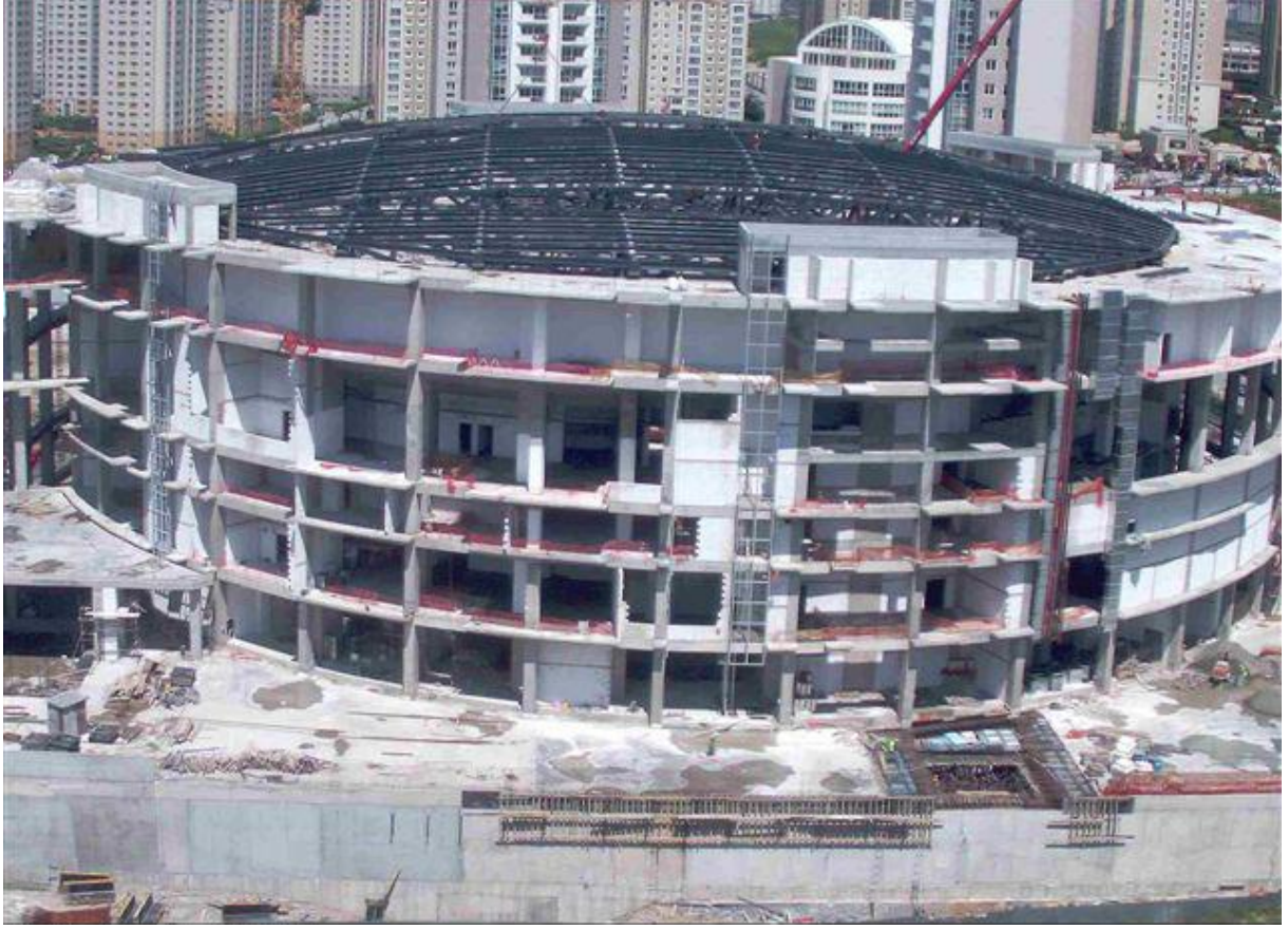
Çatı İmalatı Genel Görünümü General View of the Roof Construction
