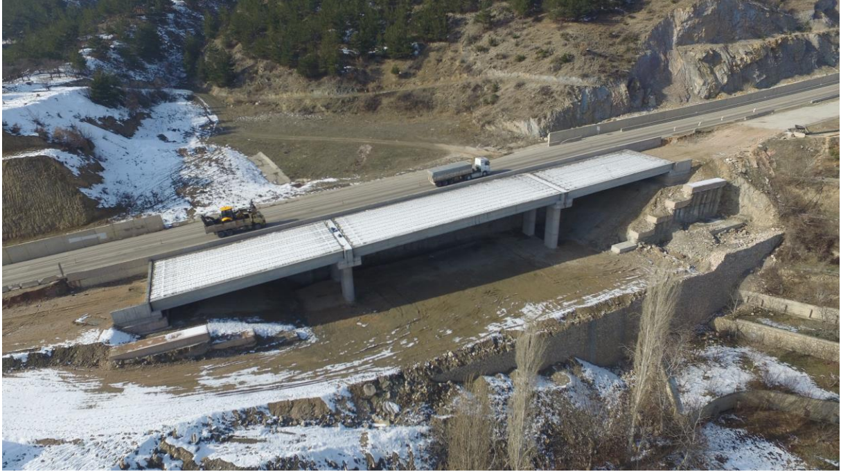
Köprü İmalat Genel Görünüm General View of Bridge Construction
