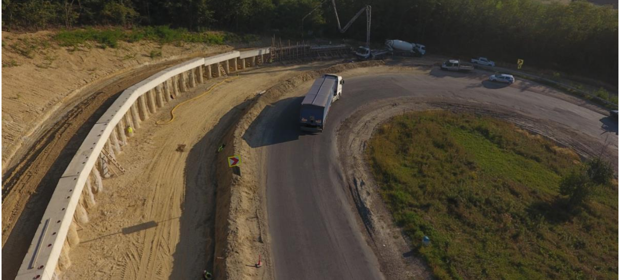
Yol İnşaat Alanından Genel Görünüm. General View of the Road
