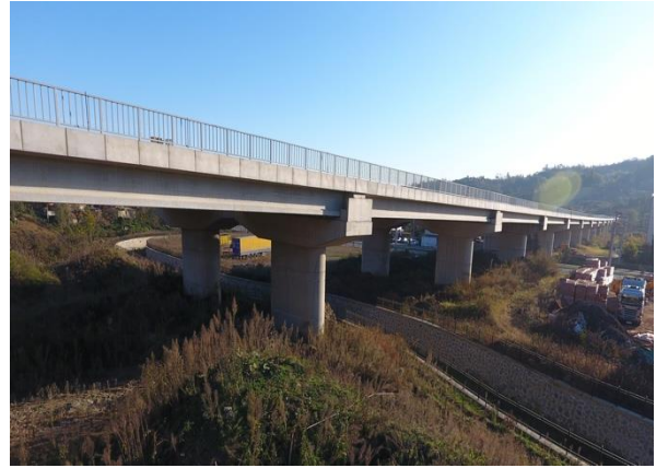
Viyadük İnşaatı Genel Görünüm General View of Viaduct Construction
