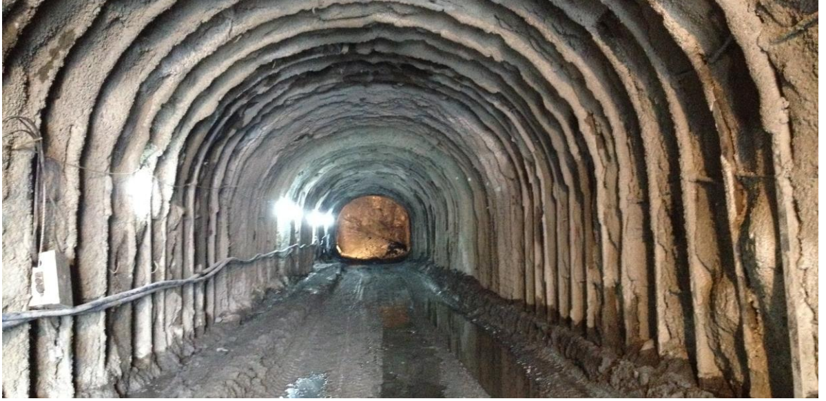
Tünel Aynası Görünümü. View of the Tunnel Face.
