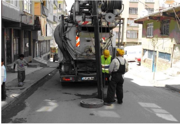
Yüksek Basıncılı Kanal Temizleme Aracı ile Kanal Temizliği Görünümü
