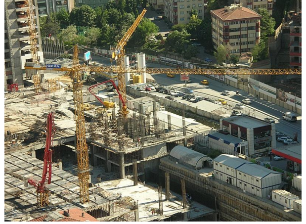
Ofis Binası İnşaatı Görünümü View of the Office Building Construction
