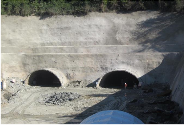
Tünel Aynası İnşaatı Tunnel Face Construction
