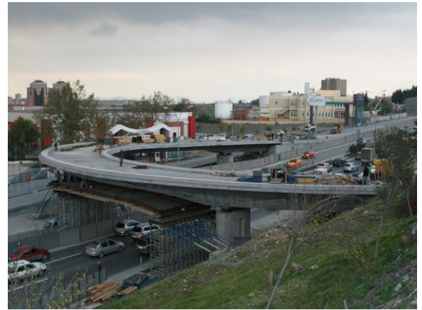
(Altın Trafik Akışı Devam Ederken) Köprü İnşaatı Görünümü. View of the Construction of the Bridge (while Traffic Flows Underneath).
