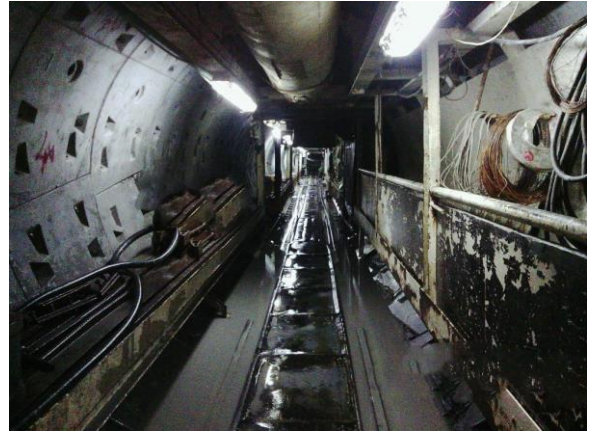
Tünel İnşaatı Görüntüsü View of the Tunnel Construction
