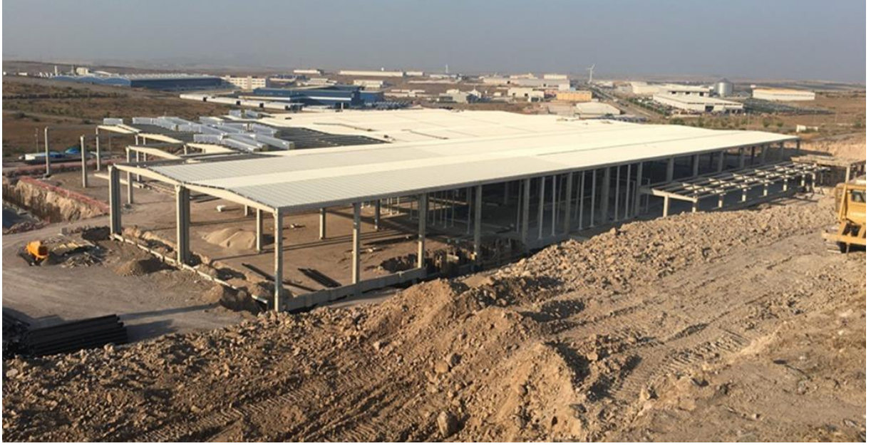
İnşaat Sahasından Genel Görünüm General View of Construction Site
