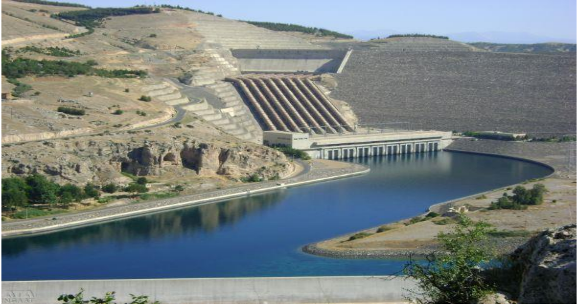
Atatürk Barajı'nın Genel Görünümü. General View of the Atatürk Dam.
