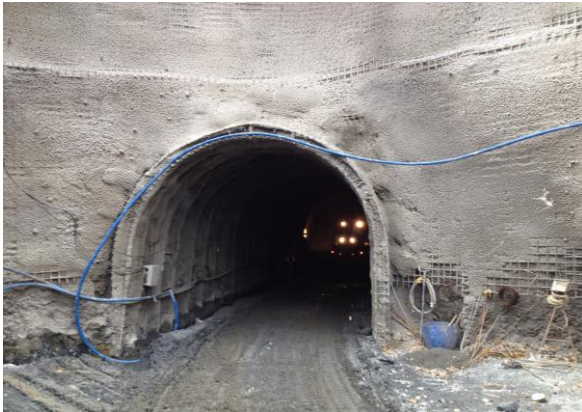
Tünel Girişi Görünümü. View of Entrance of the Tunnel.
