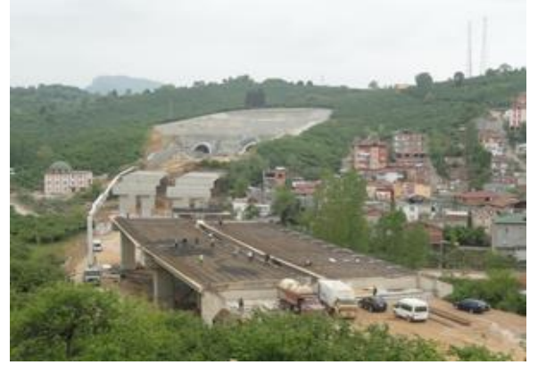
İnşaat Sahasının Genel Görünümü General View of the Construction Site
