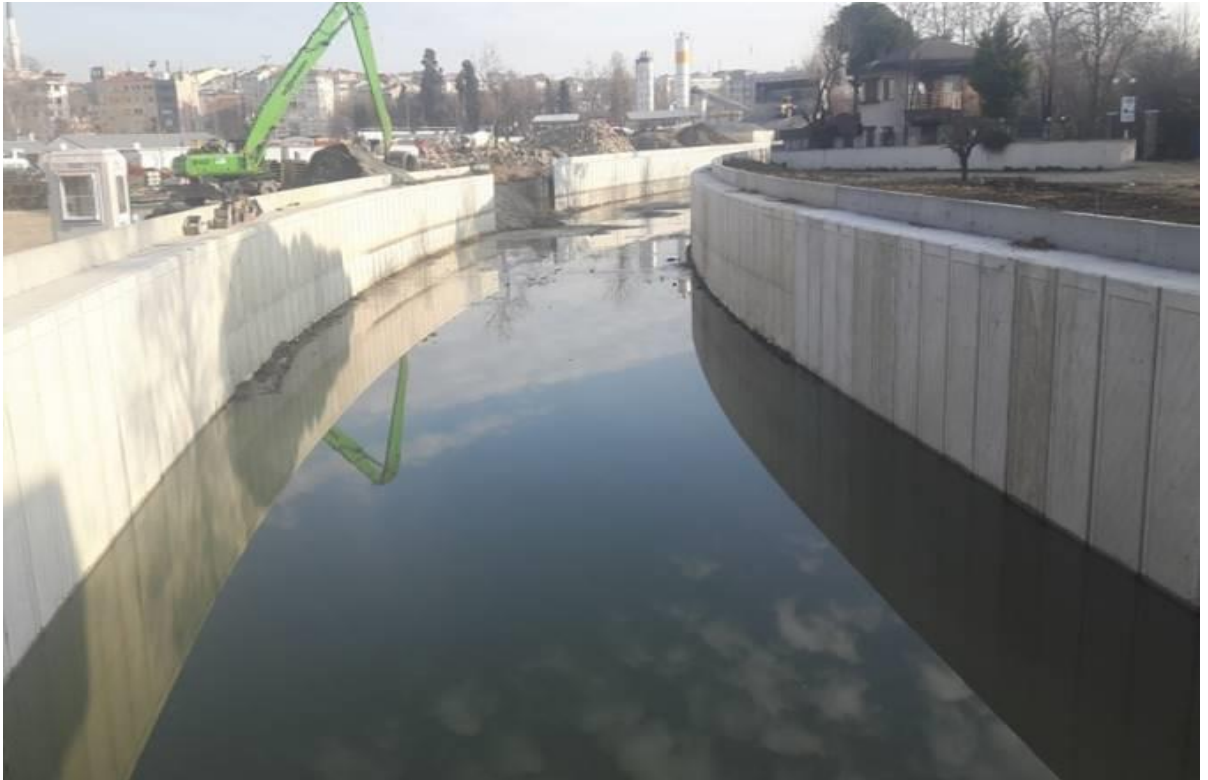
Dereden Görünüm View from Creek
