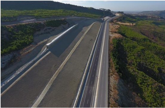
Yolun Genel Görünümü General View of the Road
