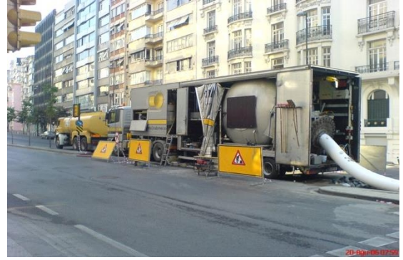
Rehabilitasyon Aracı ve Kazısız Yöntem ile Komple Kaplama İşi Görünümü
