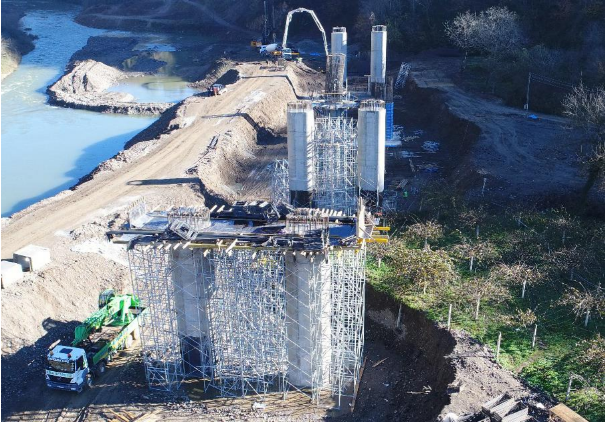
Viyadük Ayakları İmalatları Assembling of the Viaduct Piers
