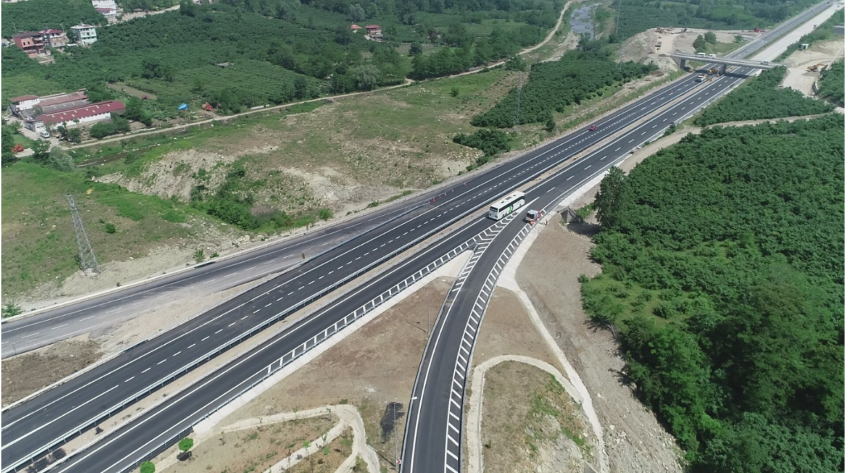
Yol İnşaat Alanından Genel Görünüm
