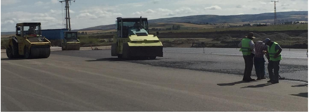
İnşaat Sahasından Genel Görünüm General View of Construction Site
