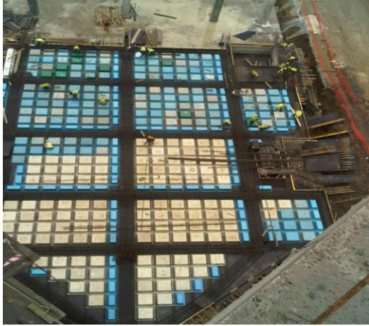
Kaset Döşeme İmalatı Görünümü View of Waffle Slab Construction
