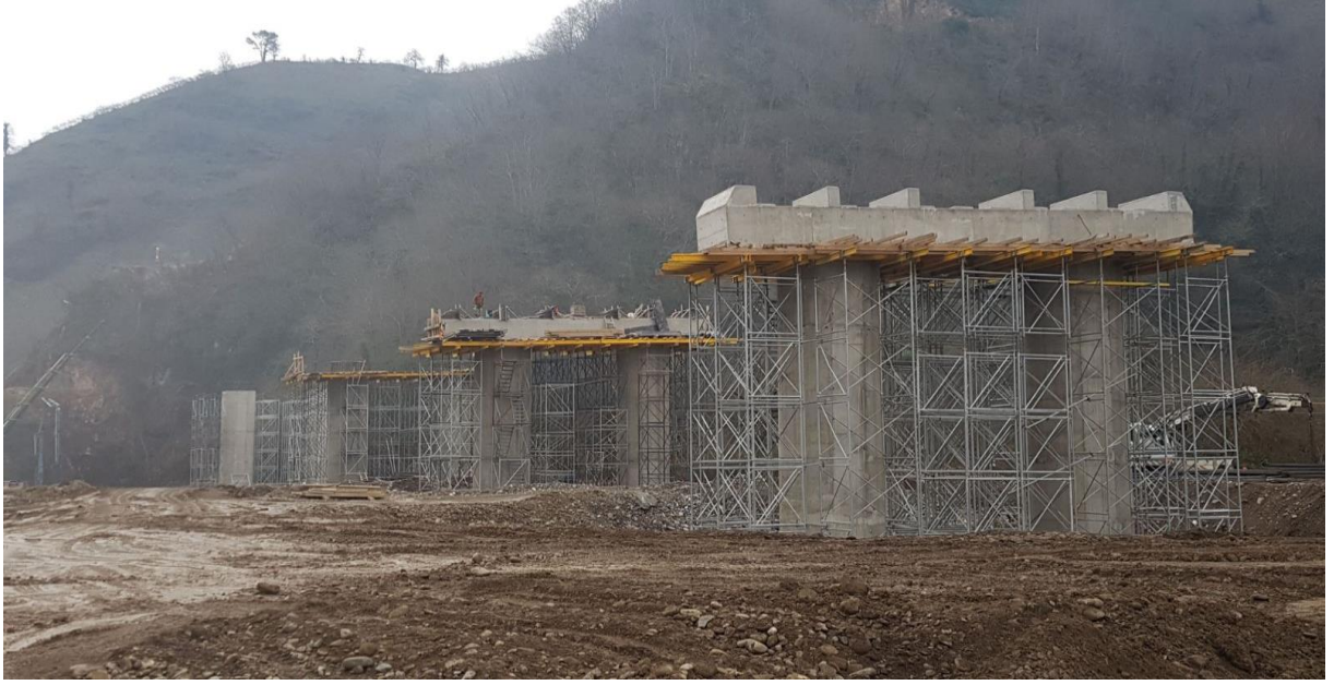
Viyadük Ayakları İmalatları Assembling of the Viaduct Piers
